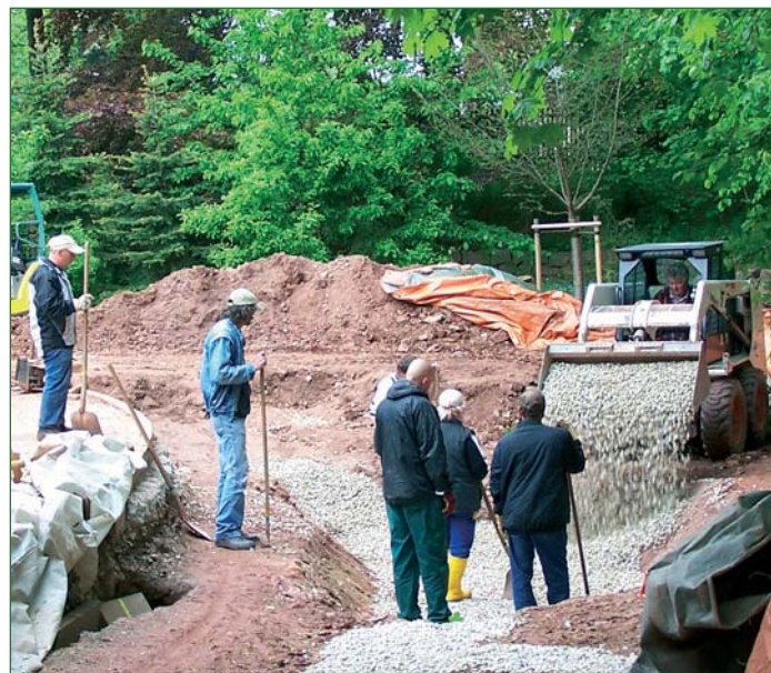
Vorbereitungen zur Fundamentlegung
